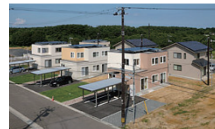
写真/六ヶ所村スマートグリッド実証実験
